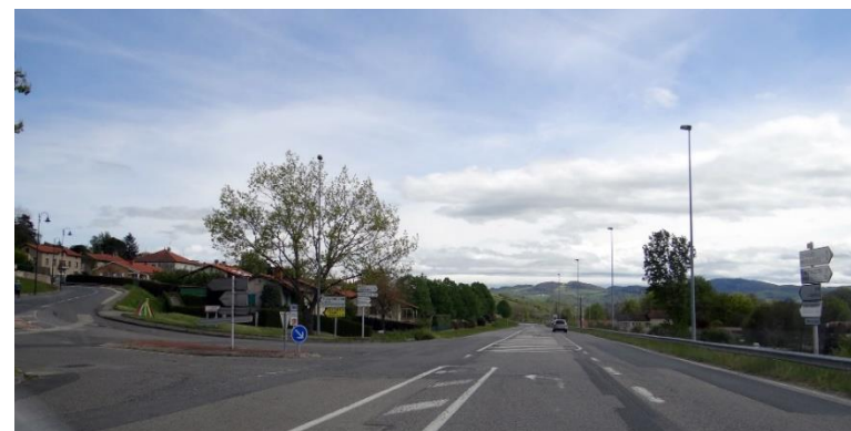
Entrée de bourg Ouest par la D81 avec éléments urbains (trottoirs, candélabres bas ...)
