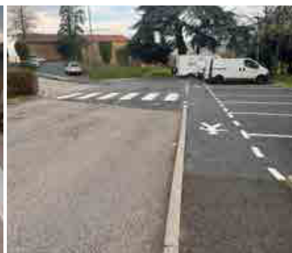
Passage piétons devant la salle Suzanne Fougerouse
